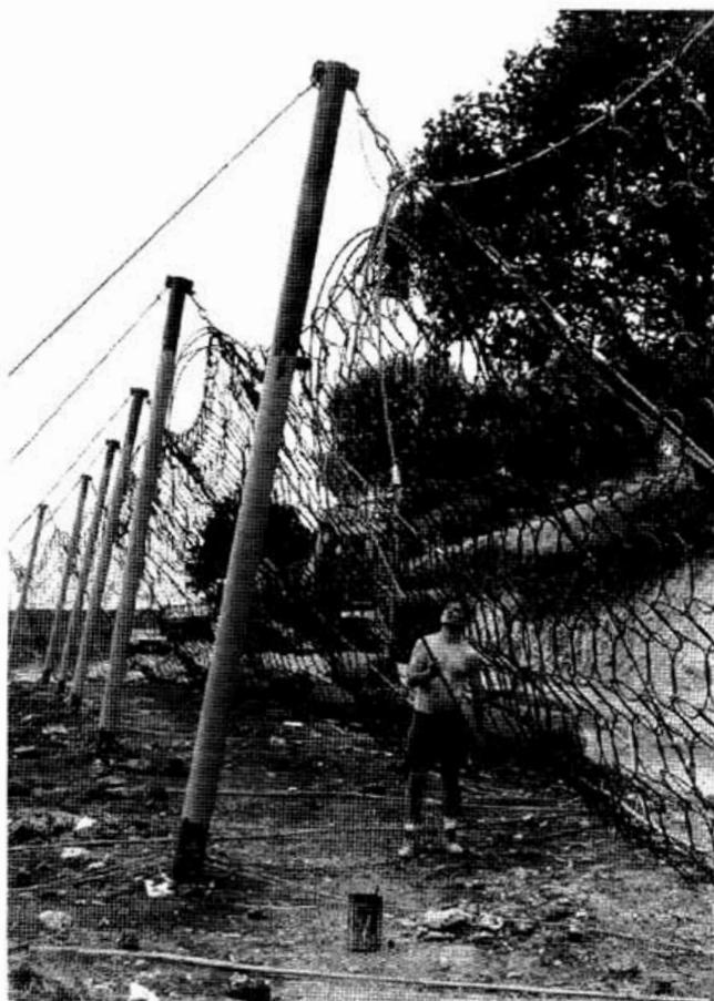
Fig. 5.4: Esempio di barriera a sacco (Fotografia Tubosider)
