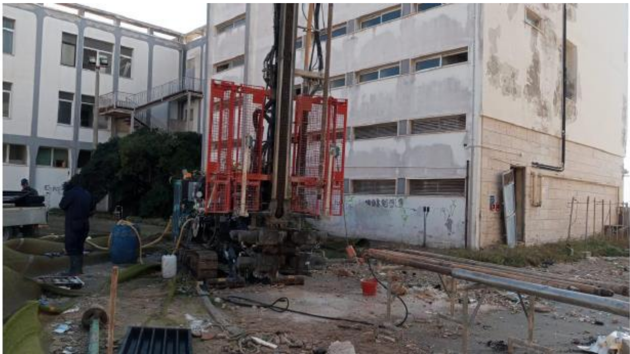
Figura 3.13 Esecuzione sondaggio a carotaggio continuo
